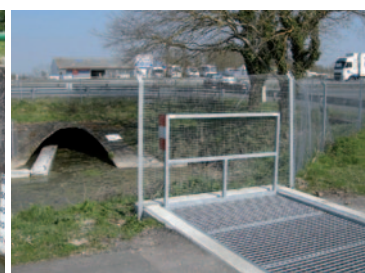
Raccordement grillage sur passage canadien RD 137
