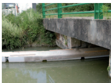
Passerelle flottante RD 110
