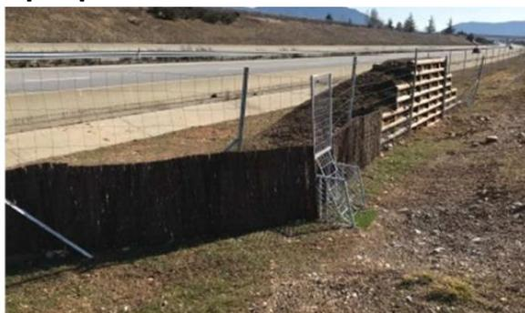
**Figure n° 42.** Rampe linéaire combinée avec une trappe posée en pied de butte. (France - photo : Cabinet X-AEQUO - VINCI Autoroutes / ESCOTA)
