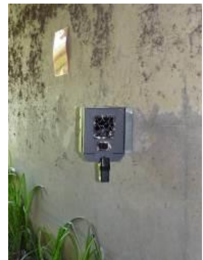
Fixation de l'APF dans ouvrage hydraulique
