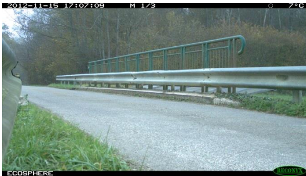
Photographie 43 : Ouvrage de type 1 (Passage fortement fréquenté par l'Homme)
