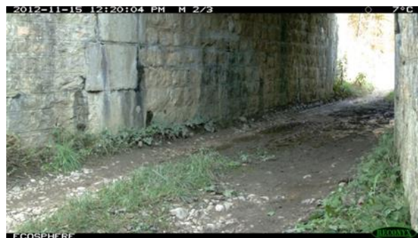
Photographie 46 : Ouvrage de type 4 (Passage inférieur avec revêtement stabilisé)
