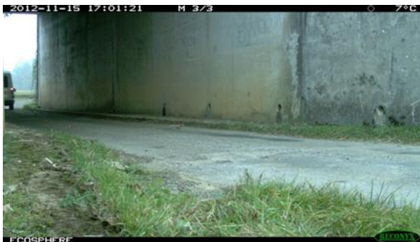
Photographie 45 : Ouvrage de type 3 (Passage inférieur avec revêtement béton)
