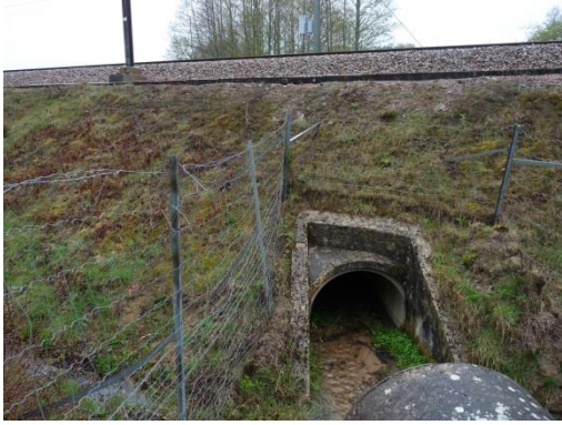
Photographie 49 : Buse : Ouvrage circulaire de taille très variable
