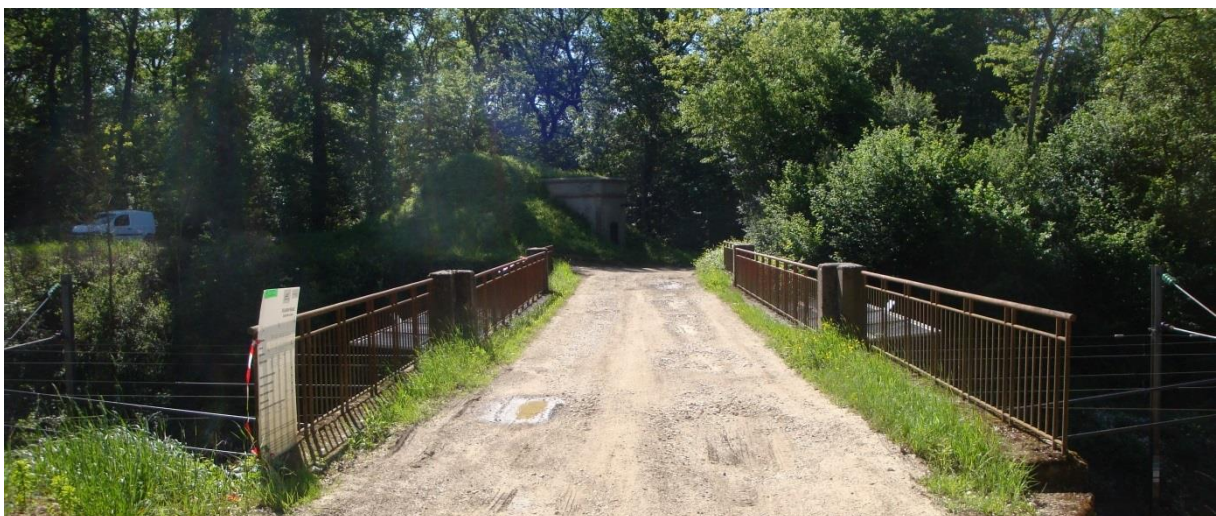
Photographie 42 : Repérage d'un ouvrage supérieur sur la ligne classique Franche-Comté – A. Plaisance – mai 2012
