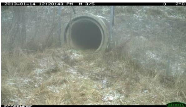
Photographie 47 : Ouvrage de type 5 (Buse hydraulique sur la LGV Est Européenne)
