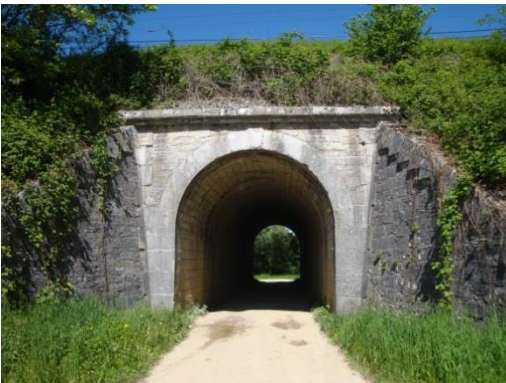
Photographie 51 : Ouvrage maçonné en béton de taille importante permettant le passage de véhicules
