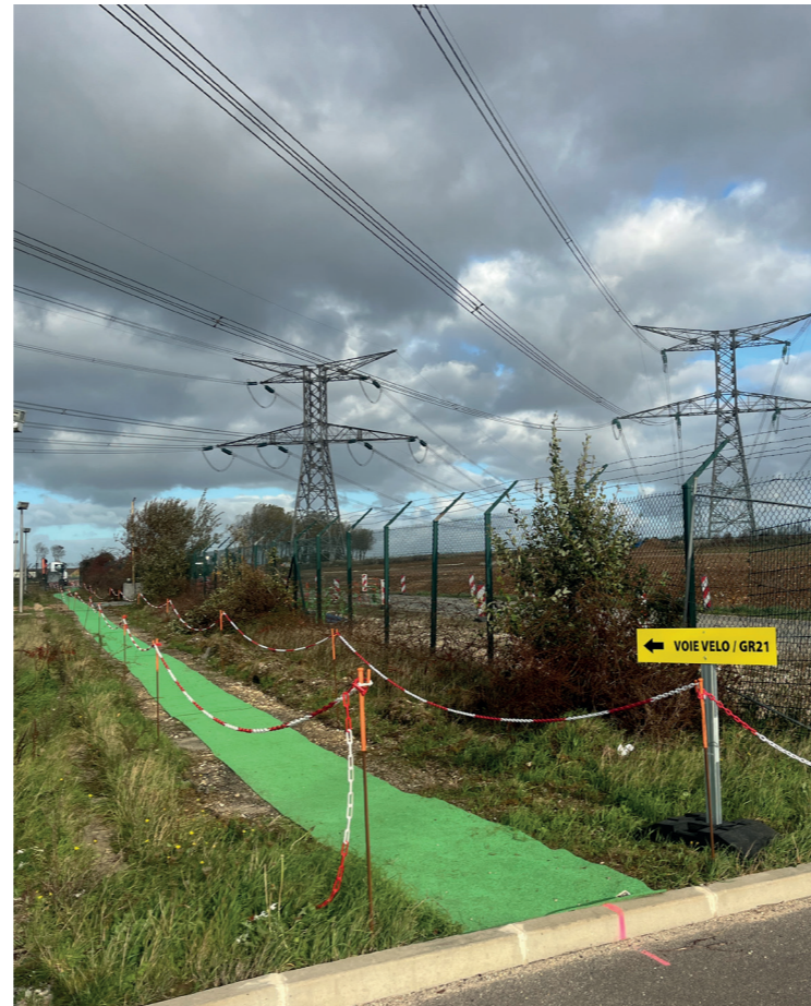
Chantier de l'EPR2
