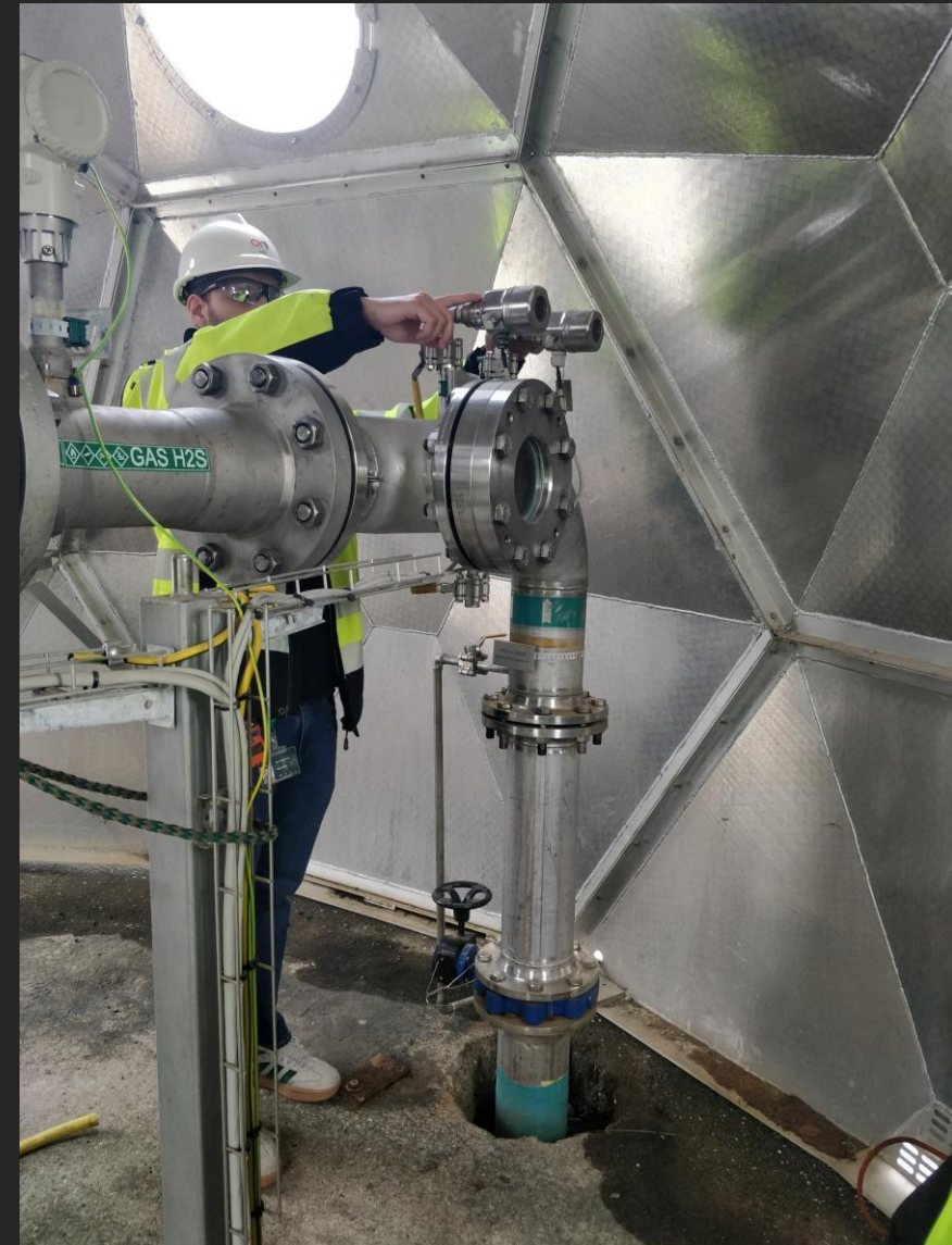
Pompe d'injection à l'intérieur de l'“igloo”
