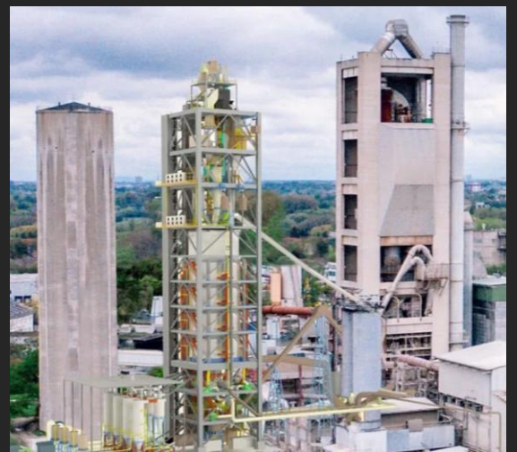
Heidelberg Materials LEILAC 2, Allemagne
