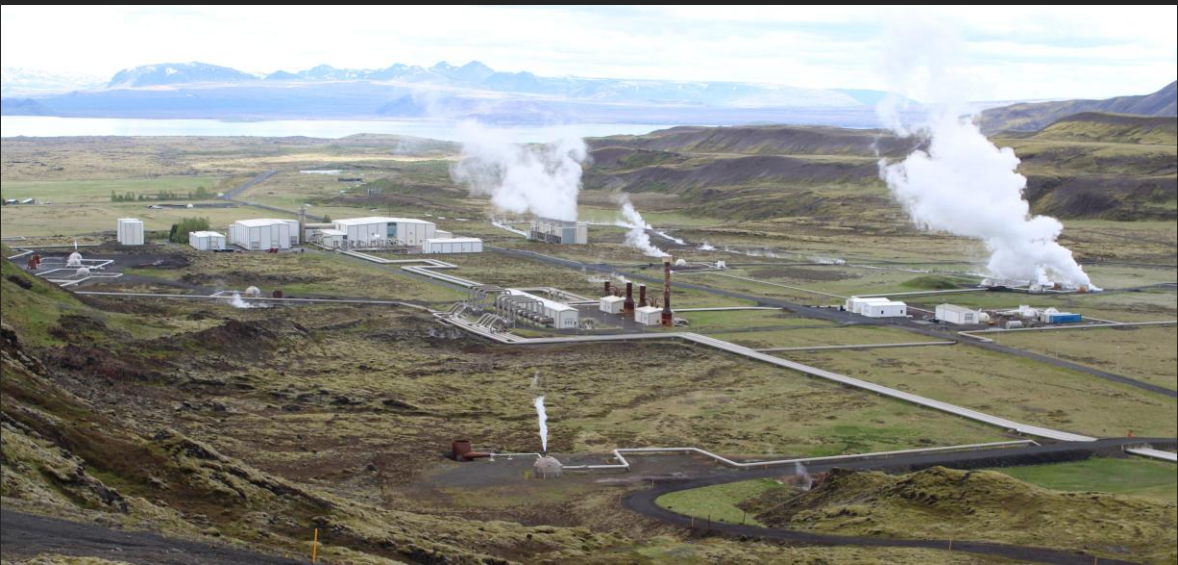
Centrale géothermique de Nesjavellir, équipée de Carbfix
