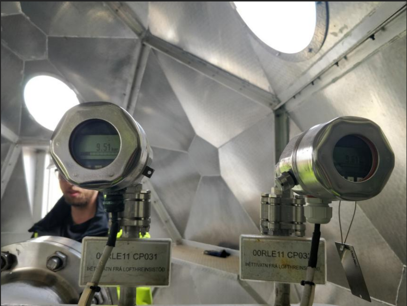
Témoin visuel et baromètres de la pompe d'injection à l'intérieur de l'“igloo” de Carbfix
