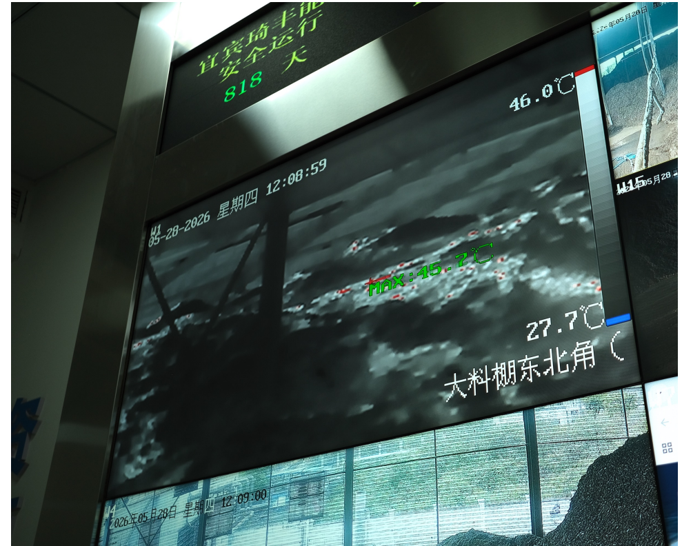
Centrale à Yibin (Sichuan) : pile de biomasse stockée en fermentation (gauche) et écrans de surveillance thermique dans la salle de contrôle (droite). Source : Camille Oulès, Mai 2026.
