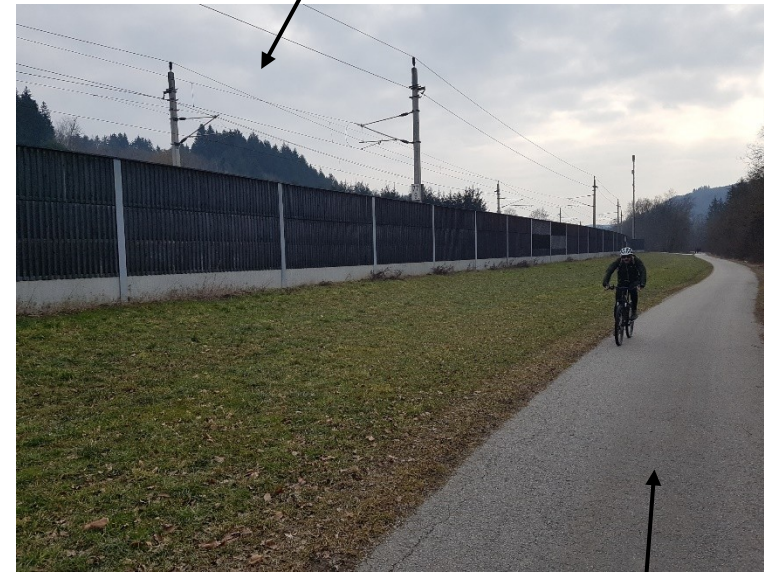
Passage piéton/ vélo au barrage
